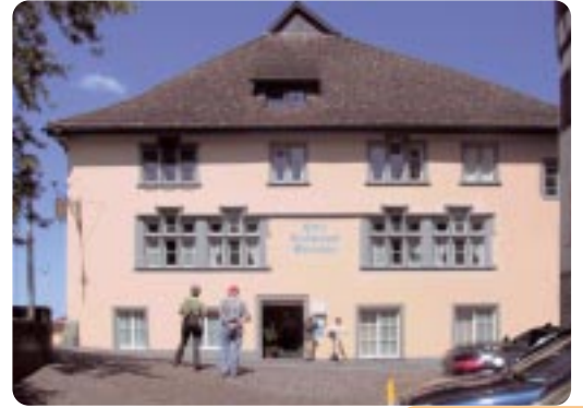
Ostfassade des Rheinfels mit den zwei original gotischen Fensterfluchten.
